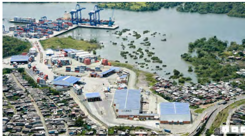
Vista aèria de les instal·lacions de TCBUEN, entre els barris de la Inmaculada i Santa Fe
